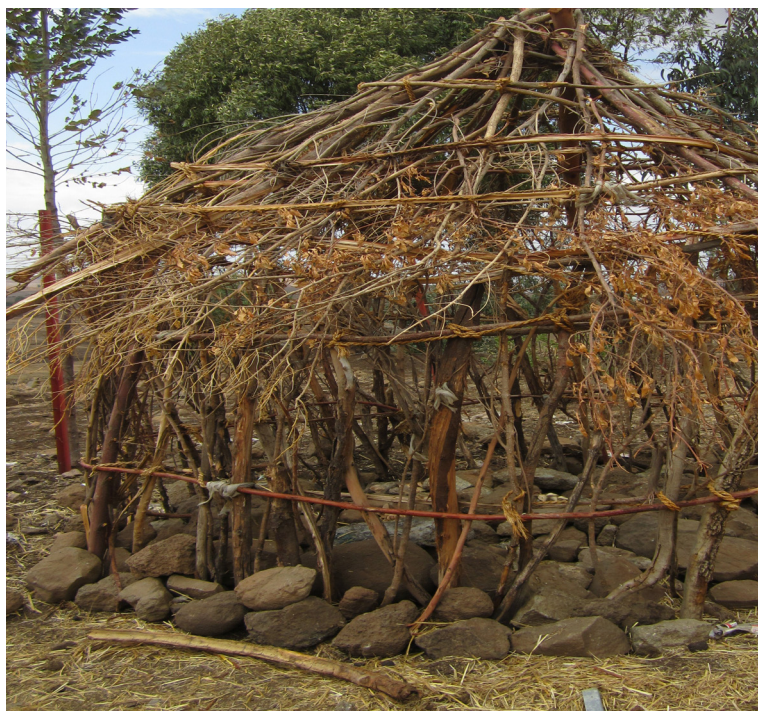
Latrine d'un ménage partiellement construite, Gondar Nord, faite en matériaux locaux disponibles.
